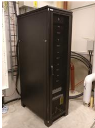
EnergyHub XL Rackskåp 28-140 kW Upp till 140kW växelriktarkapacitet 100A fasbalansering
