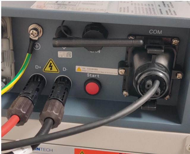
Bild 1. Inkoppling av BMS med en stapel.
