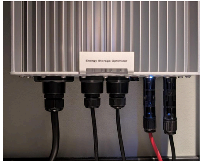
Bild 2. Inkoppling av ESO15.
